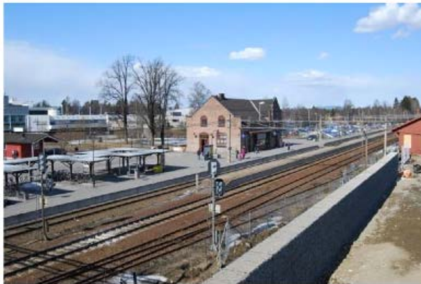
Stasjonsområdet sett fra sørøst ved Jessheimsbrua.
