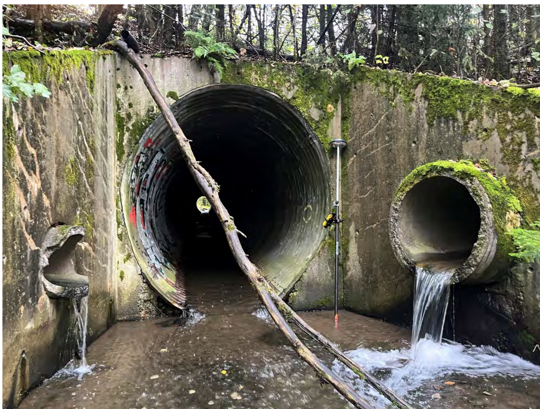
Figur 1-2 Kulvert under E6 i midten med det som anslås å være drenering fra E6 til høyre og venstre. Bildet er tatt på vestsiden av E6 og man ser mot øst. Plassering av kulvert er vist i Figur 1-1
